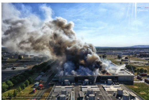
Incendie du SIAAP à Saint-Germain-en-Laye (Yvelines) en 2019 | Crédits : Sdis 78
