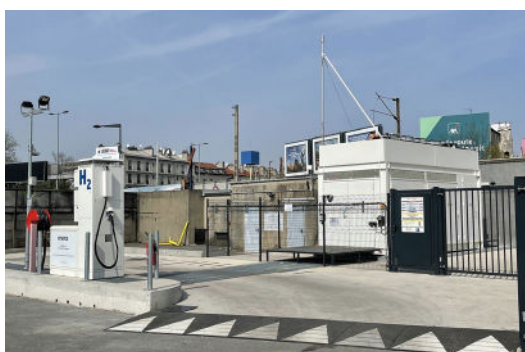
Station de distribution d'hydrogène - Porte de la Chapelle (93) | Crédits : Hysetco
