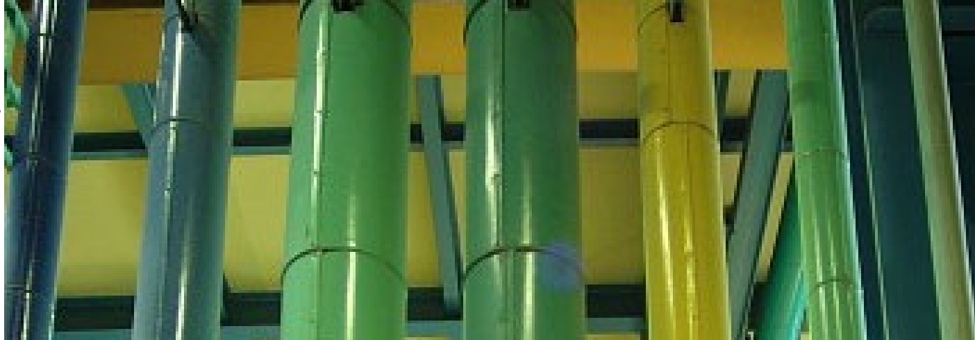
Usine d'incinération des ordures ménagères | Crédits : Laurent Mignaux - Terra
